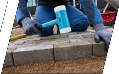
Befüllung des Hammerkopfes mit Metallkugeln gewährleistet kein Zurückprallen beim Schlagen. Volle Schlagkraft überträgt sich auf das Werkstück
